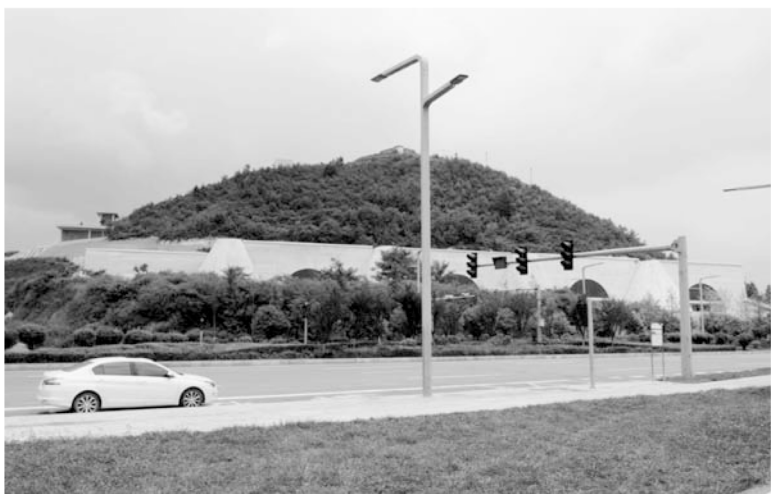
山中に建設されたテンセントのデータセンター
